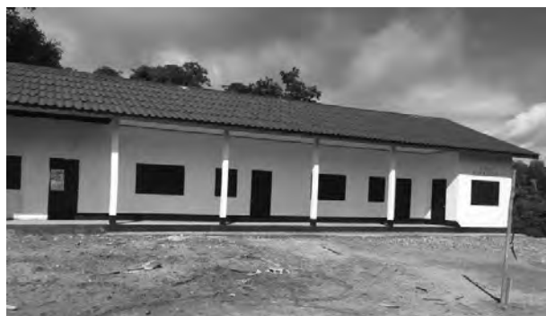
図 2：完成したプークー村の小学校 (2020 年 9 月)
